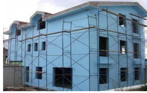
Şekil 172: Yalıtım malzemesi uygulaması
