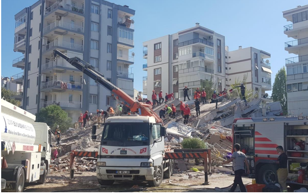
Şekil 3.26 – Yağcıoğlu Sitesi B Blok'un enkazı (çapraz görünüm)
