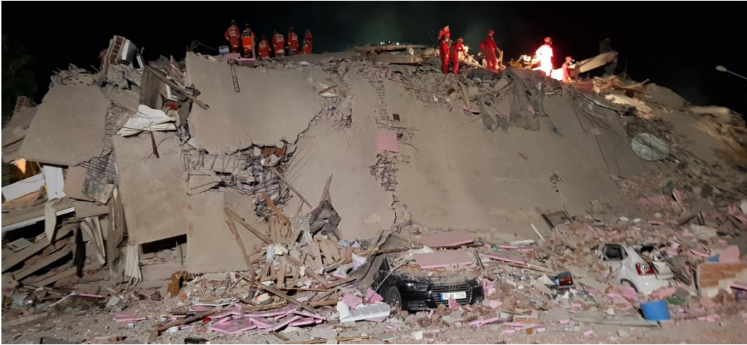
Şekil 3.7 – Rıza Bey Apartmanı'nın enkazı (yan görünüm)
