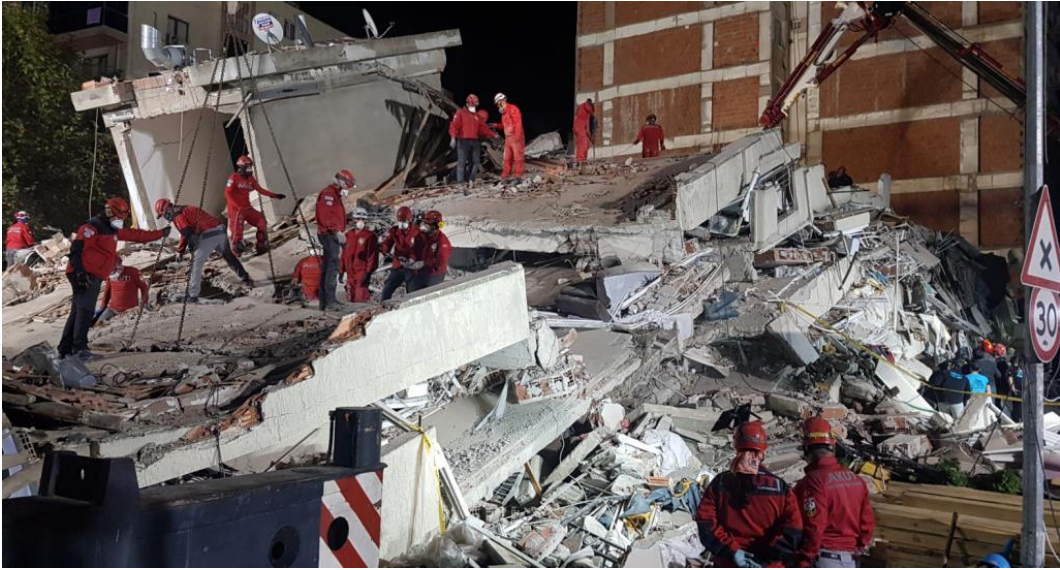
Şekil 3.15 – Doğanlar Apartmanı'nın enkazı (çapraz görünüm)
