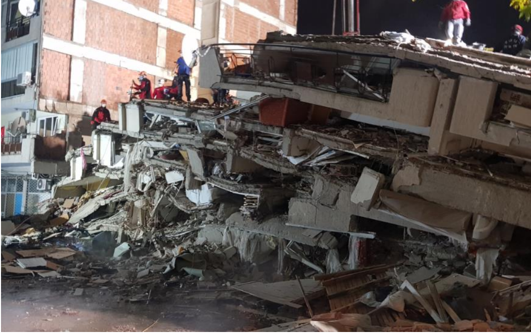
Şekil 3.14 – Doğanlar Apartmanı'nın enkazı (yan görünüm)
