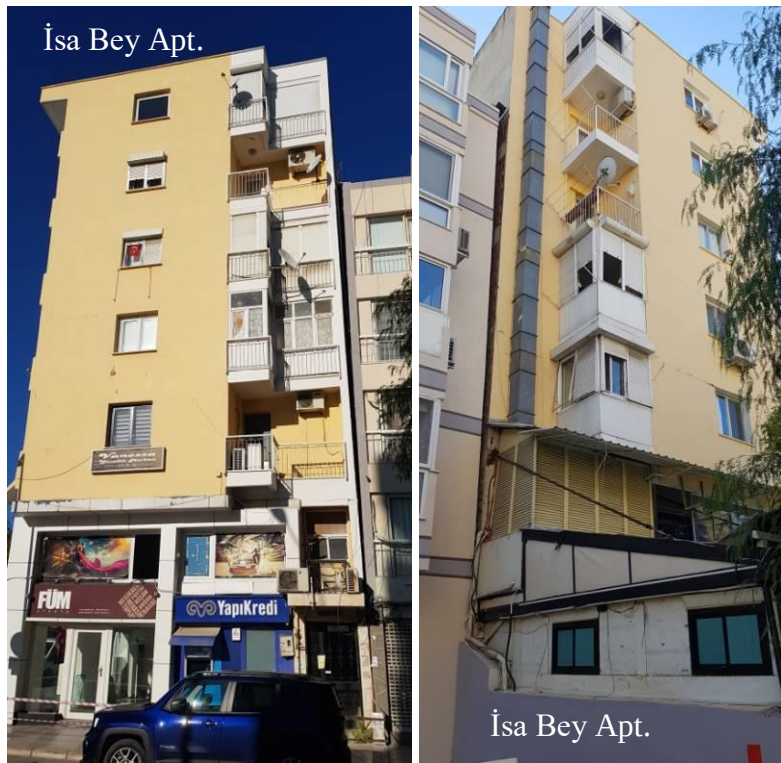
Şekil 3.54 – Ayrılan ve yana yatan binalar
