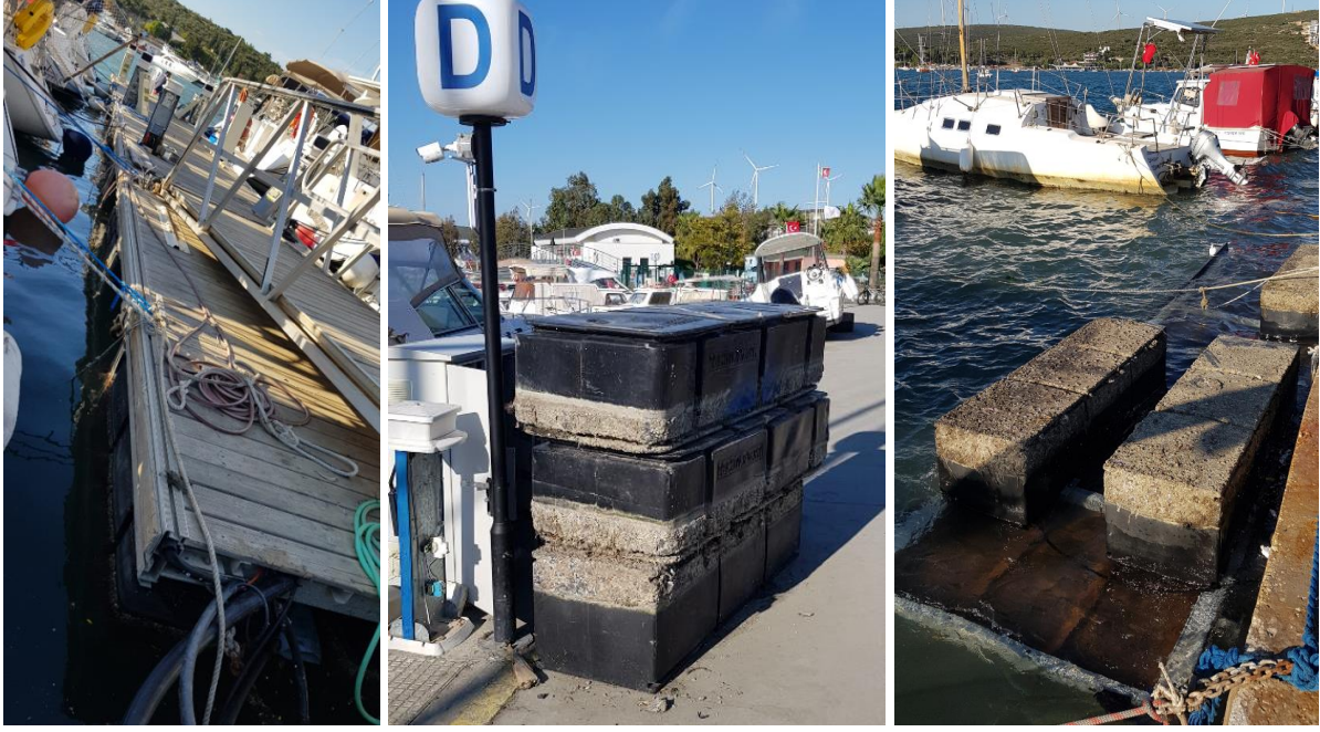
Şekil 5.3 – Kopmuş ve hasar almış pantonlar
