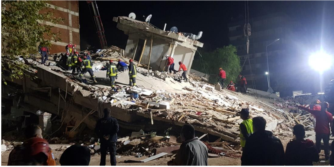
Şekil 3.13 – Doğanlar Apartmanı'nın enkazı (çapraz görünüm)
