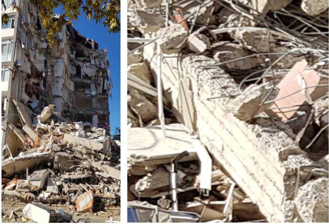
Şekil 3.41 – Karagöl Apartmanı enkazı ve çeşitli donatı detayları
