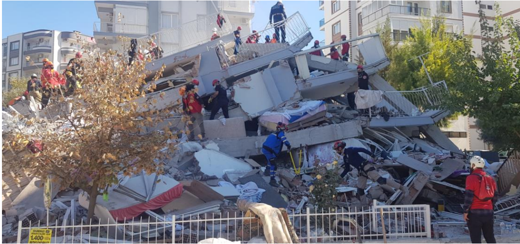
Şekil 3.27 – Yağcıoğlu Sitesi B Blok'un enkazı (yan görünüm)
