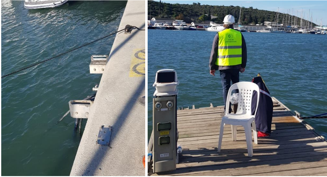
Şekil 5.4 – Panton kopma bölgeleri
