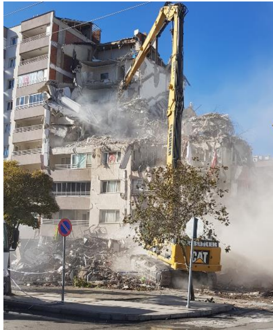
Şekil 3.36 – Yılmaz Erbek Apartmanı Kuzey Blok'un yıkımı
