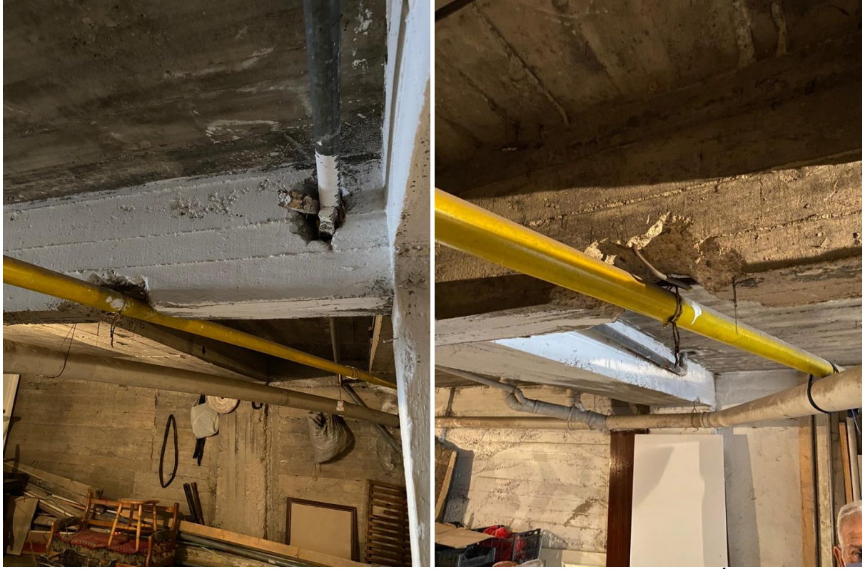
Şekil 3.75 – Kullanım aşamasında kirişe verilen hasarlar (Karşıyaka, İzmir)
