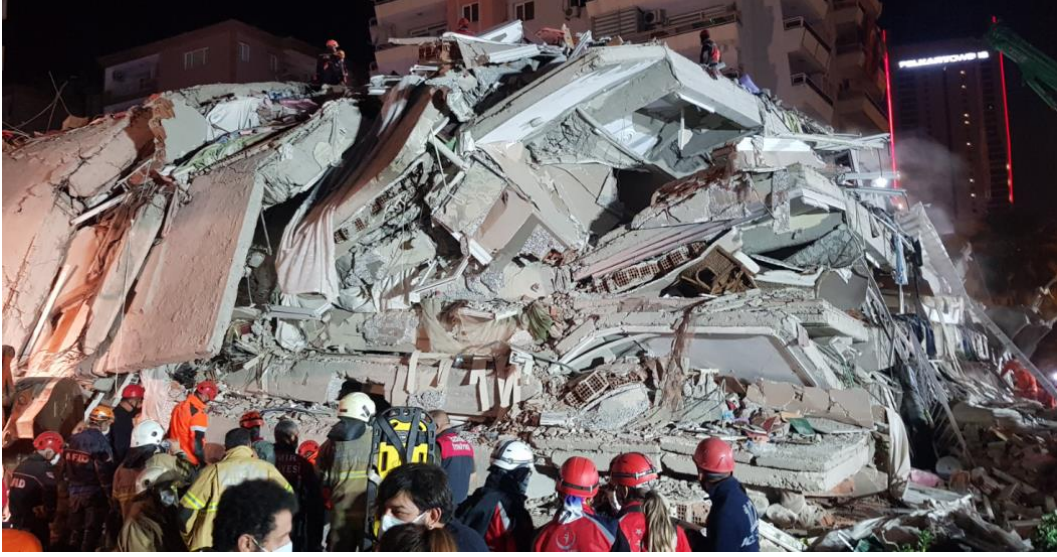
Şekil 3.6 – Rıza Bey Apartmanı'nın enkazı (çapraz görünüm)
