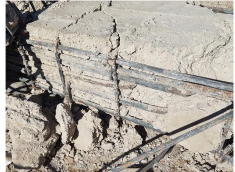
Şekil 3.23 – Emrah Apartmanı'ndaki bazı yapısal elemanların donatı detayları
