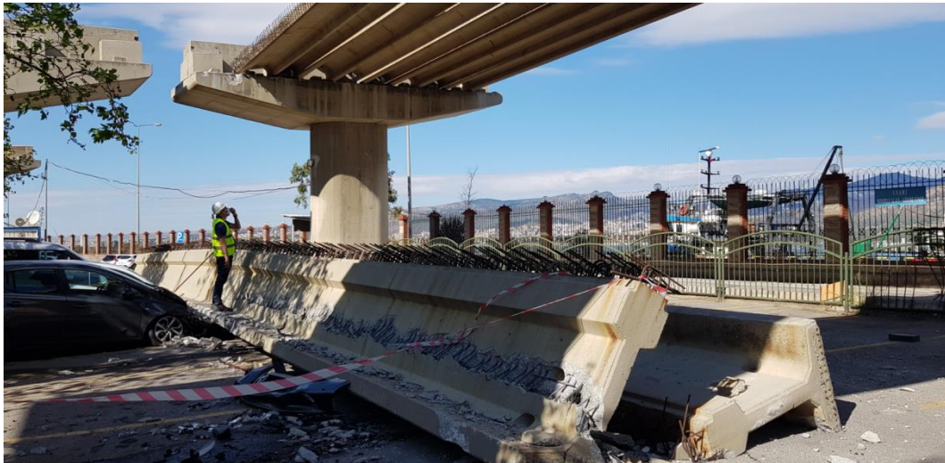
Şekil 4.4 – Düşen kirişlerin görünümü (3)
