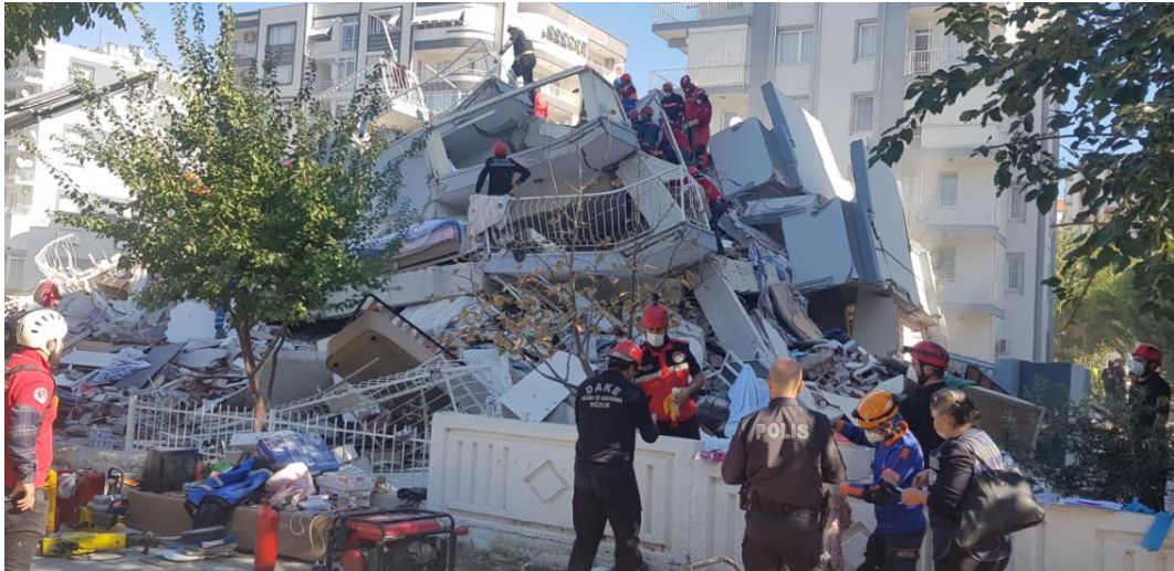
Şekil 3.28 – Yağcıoğlu Sitesi B Blok'un enkazı (çapraz görünüm)
