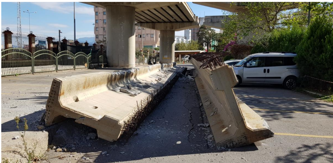
Şekil 4.2 – Düşen kirişlerin görünümü (1)
