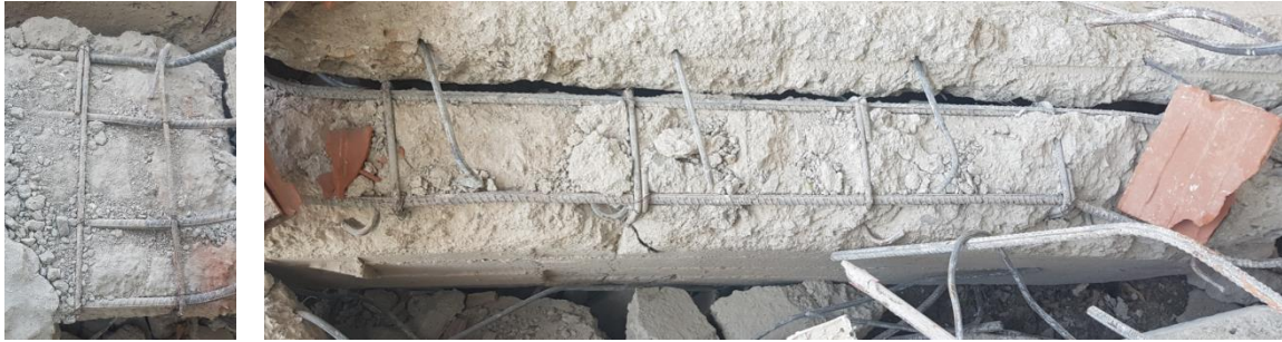
Şekil 3.17 – Doğanlar Apartmanı’nın enkazındaki bazı yapısal elemanların donatı detayları
