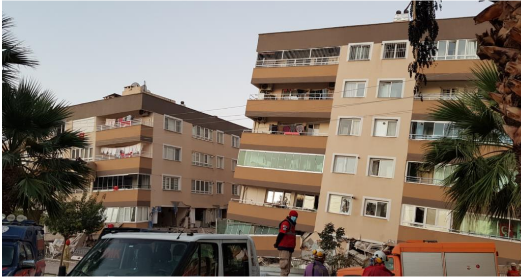
Şekil 3.44 – Barış Sitesi enkazı (ön görünüm)
