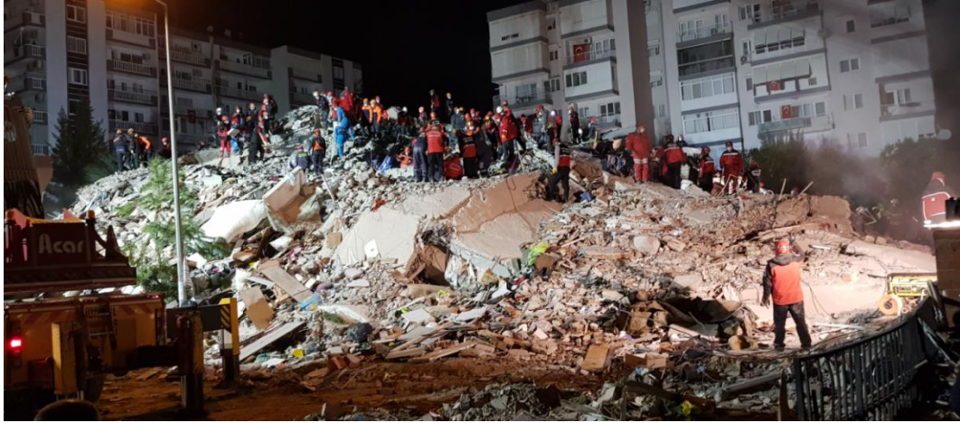
Şekil 3.20 – Emrah Apartmanı'nın enkazı (çapraz görünüm)
