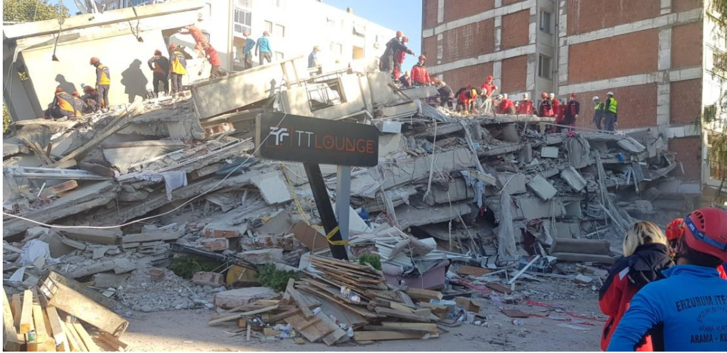
Şekil 3.16 – Doğanlar Apartmanı’nın enkazı (yan görünüm)
