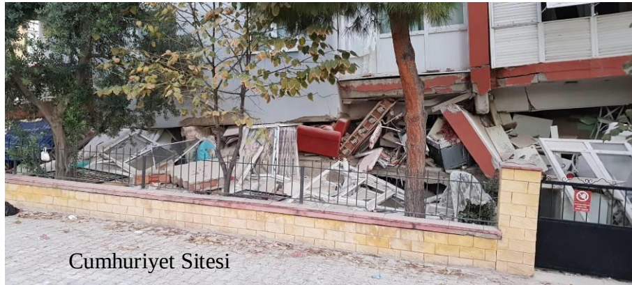
Şekil 3.66 – Alt katı veya alt birkaç katı göçen binalar
