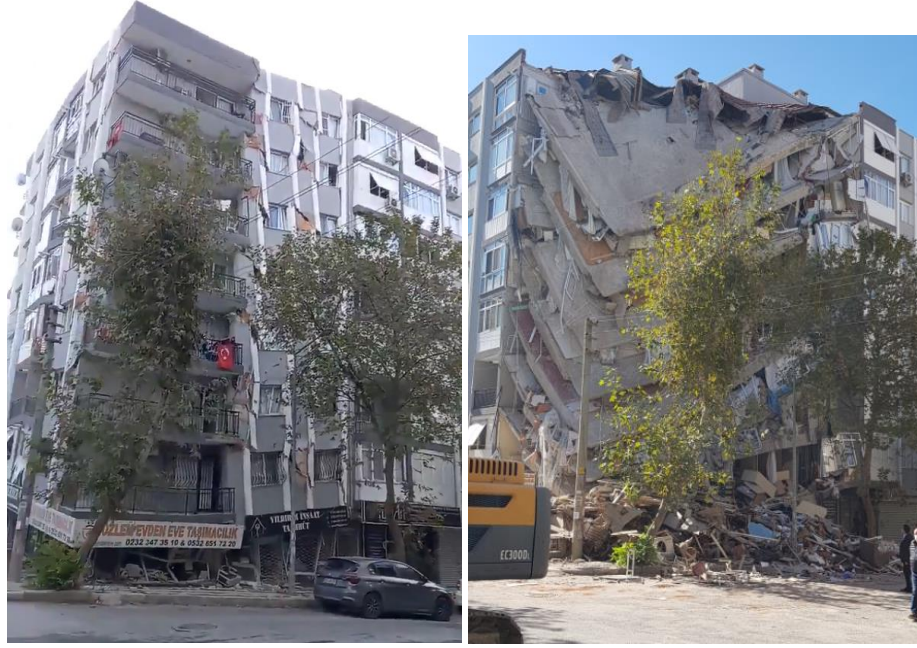
Şekil 3.68 – Karagül Apartmanı’nın göçme anı ve sonrası (Posta, 2020)
