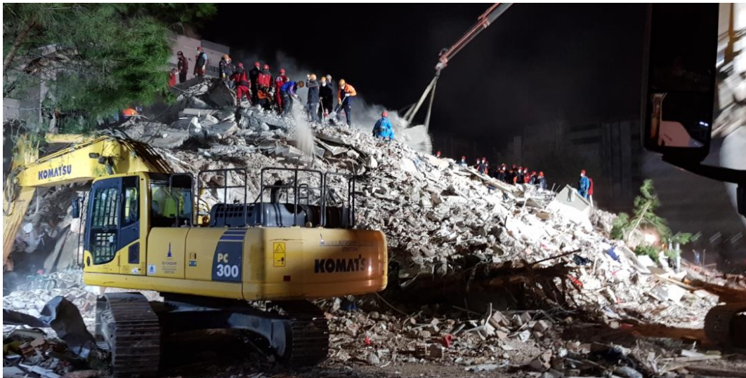
Şekil 3.21 – Emrah Apartmanı'nın enkazı (çapraz görünüm)
