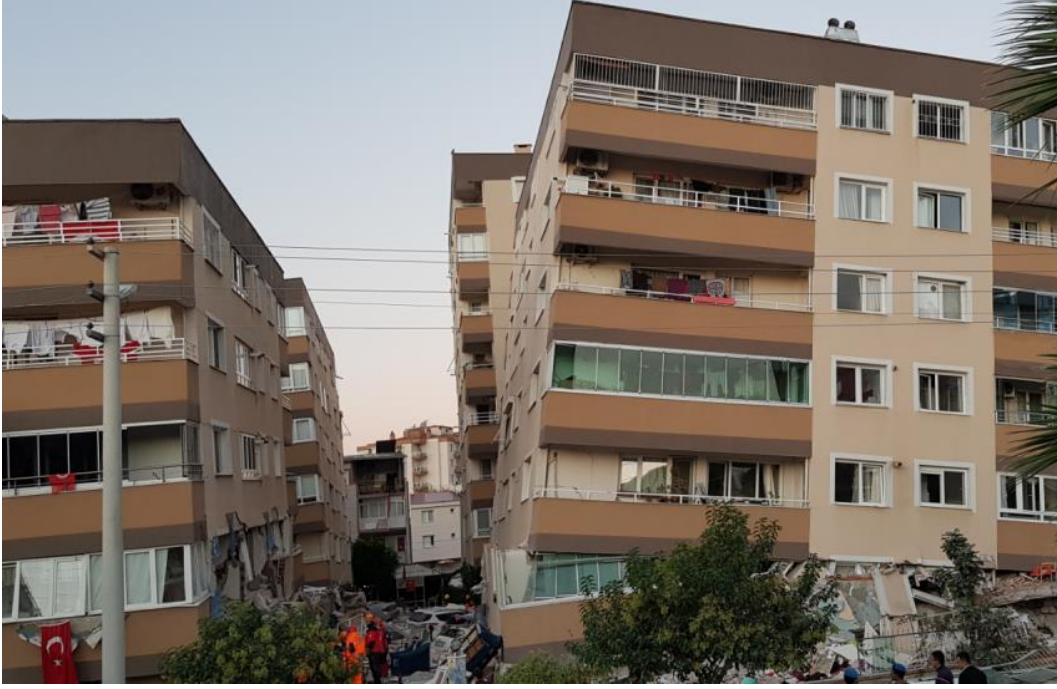
Şekil 3.45 – Barış Sitesi enkazı (ön görünüm)
