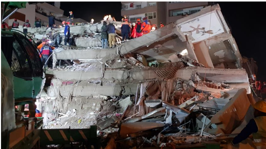
Şekil 3.8 – Rıza Bey Apartmanı'nın enkazı (çapraz görünüm)
