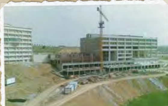
Yeni Hukuk Fakültesi İnşaatı
