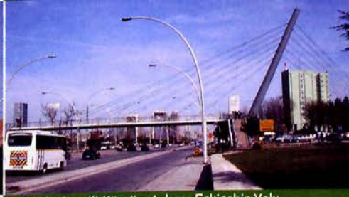
Kablo Gergili Köprü - Ankara Eskişehir Yolu
