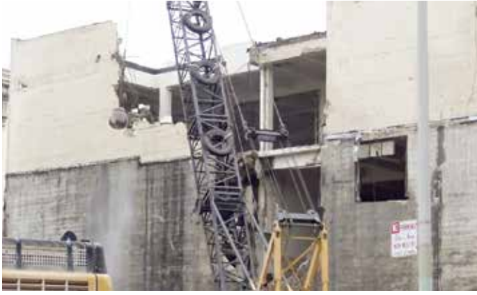
Şekil 3 – Yıkım topunun kullanıldığı yıkım tipi
