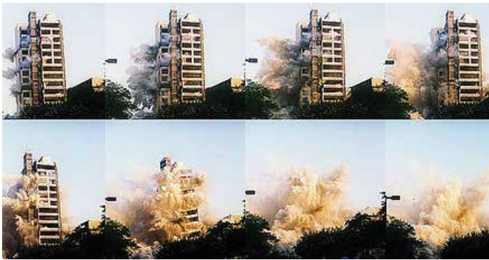
Şekil 4 – Patlayıcı kullanılan yıkım tipi
